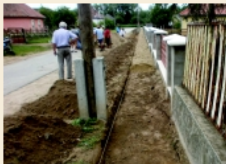
Járdaépítés a Kossuth utcában
